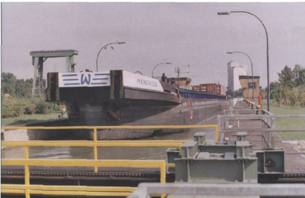
Mit Containern beladenes Großmotorgüterschiff in der Schleuse Dorsten
