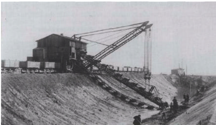
Eimerkettenbagger im Einsatz
