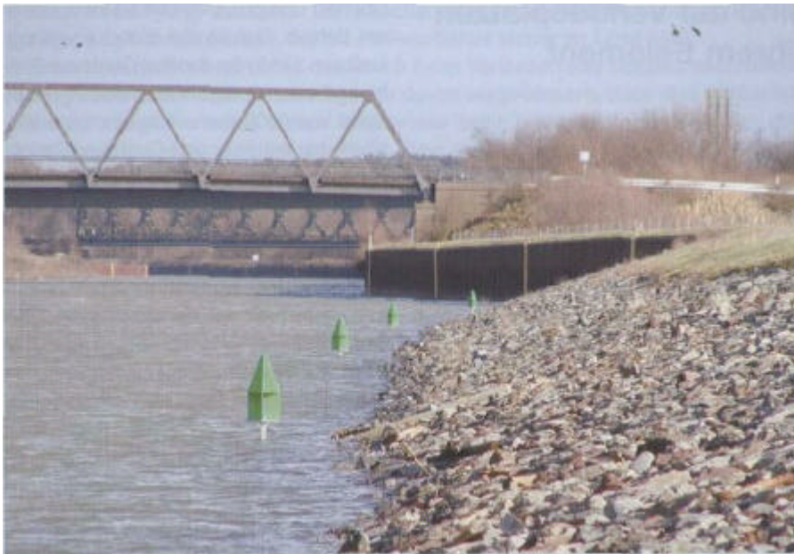
Abb. 4: Südufer der Bergbauvorsorgestrecke
